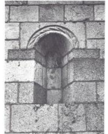
Hørning kirke, tilmauret vindue i korets østgavl. Foto: P.P. 1987.
