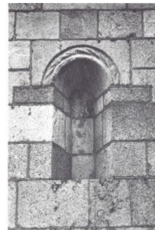
Hørning Kirke, tilmauret vindue i korets østgavl. Foto: P.P. 1987.
