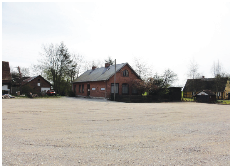
Lykkeskovej 1 nedrevet og har efterladt en åben plads. Hørning kan styrkes gennem ny bebyggelse, men den skal understøtte byens skala og struktur.
